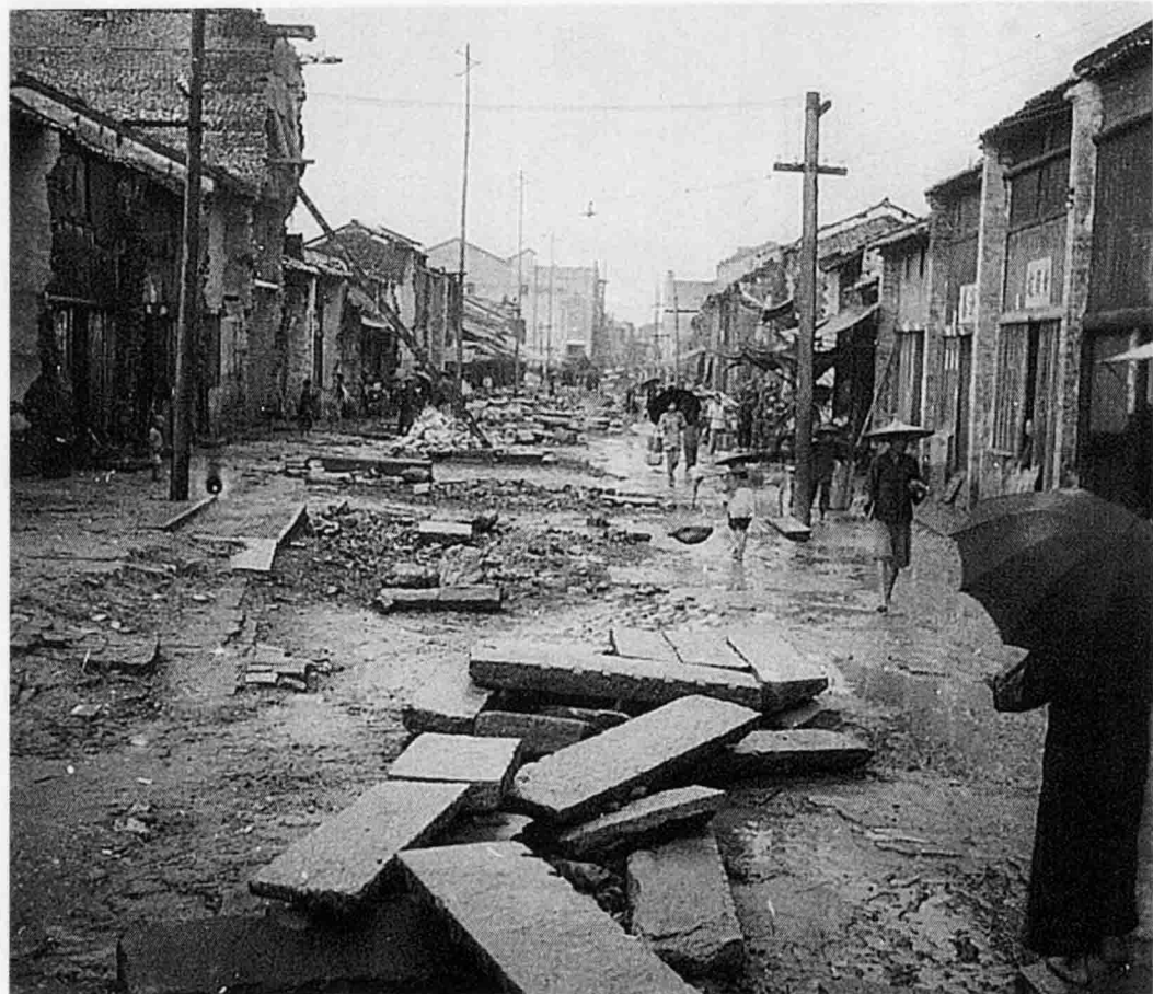
正在拆建中的城镇街道
