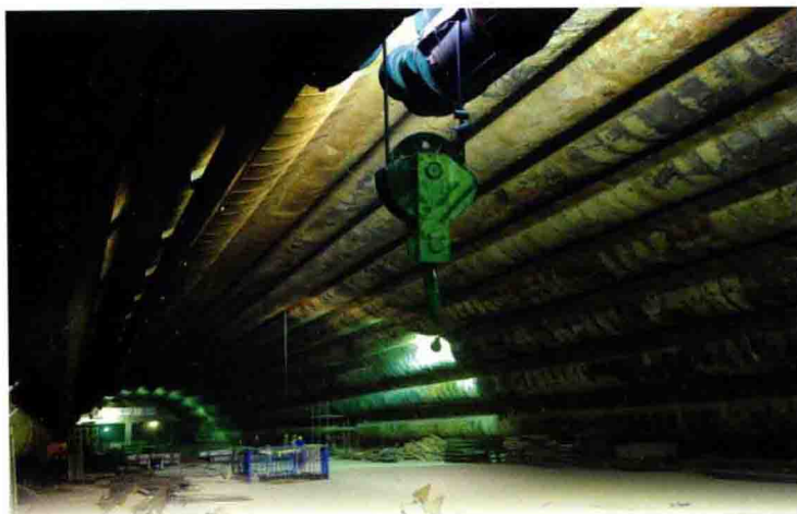
沈阳地铁二号线新乐遗址站采用韩国新管幕(NTR)工法修建
