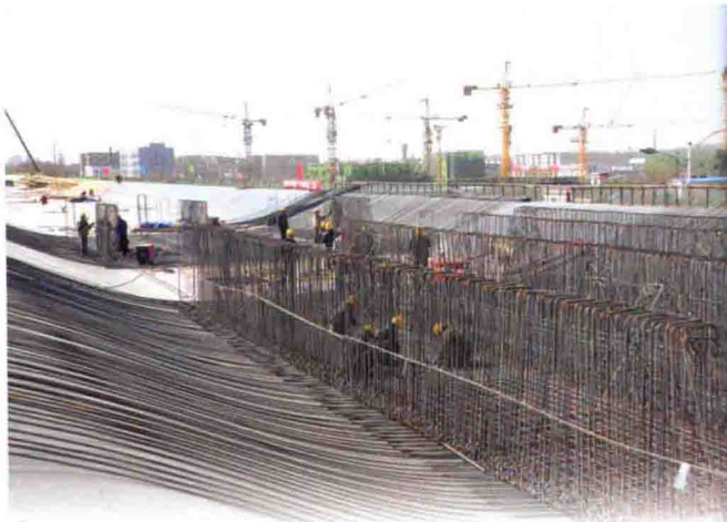
东二环快速路施工现场
