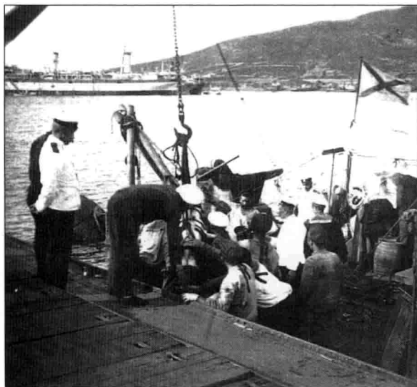
▲ ▼ 正为“有力”号更换75毫米炮管的俄国舰员，照片摄于1904年9月；但短短两个月之后，该舰就在旅顺港外被日军水雷严重炸毁。
