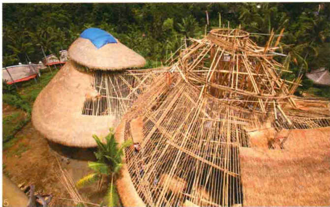
5 施工中的主建筑屋顶 6 茅草屋顶外观 7 稻田和蔬果园 8 建筑模型
