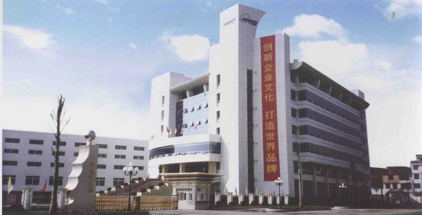
技术中心大楼
