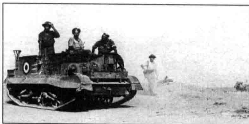
▲ 这辆于1948年10月被以色列军队俘获的布伦机枪车还保留了埃及部队的标志，不过它的以色列车组已经上面喷涂上由3个箭头构成的以色列南部军区识别标志
