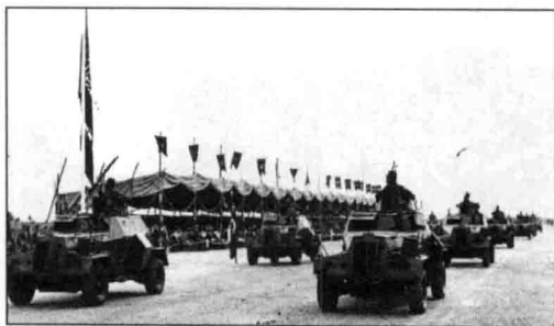
▲ 在阿拉伯联军中,埃及拥有当时整个中东最先进的装甲部队——当然,主要是二战时期的英式装备。图中就是一队英制猎手Mk.III轻型侦察车正在接受检阅,尽管只装备有一门2磅反坦克炮和一挺布伦轻机枪,但用于对付同时期的以色列装甲车却是足够了
