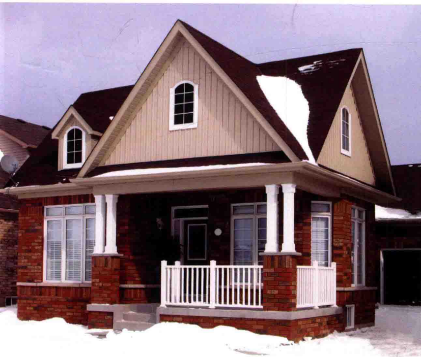
建筑整体小巧而精致，规矩的方形立面体，相交的三角形坡屋顶，塑造出一个几何感很强的建筑立面。
