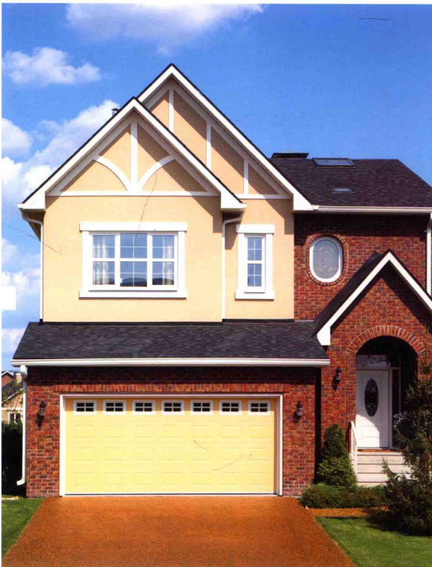
利用外挑与建筑的进深变化，打造多重立面效果，同时也很实用。
