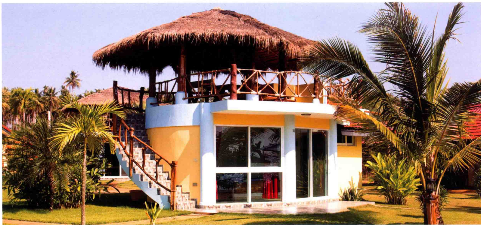
在钢筋水泥的主建筑之上，设置一座木草结构的廊亭，将现代与传统完美地结合在一起。
