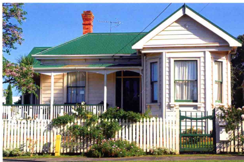
外挑的户外门廊，凸出的六角起居室，全木质建筑小而精致。
