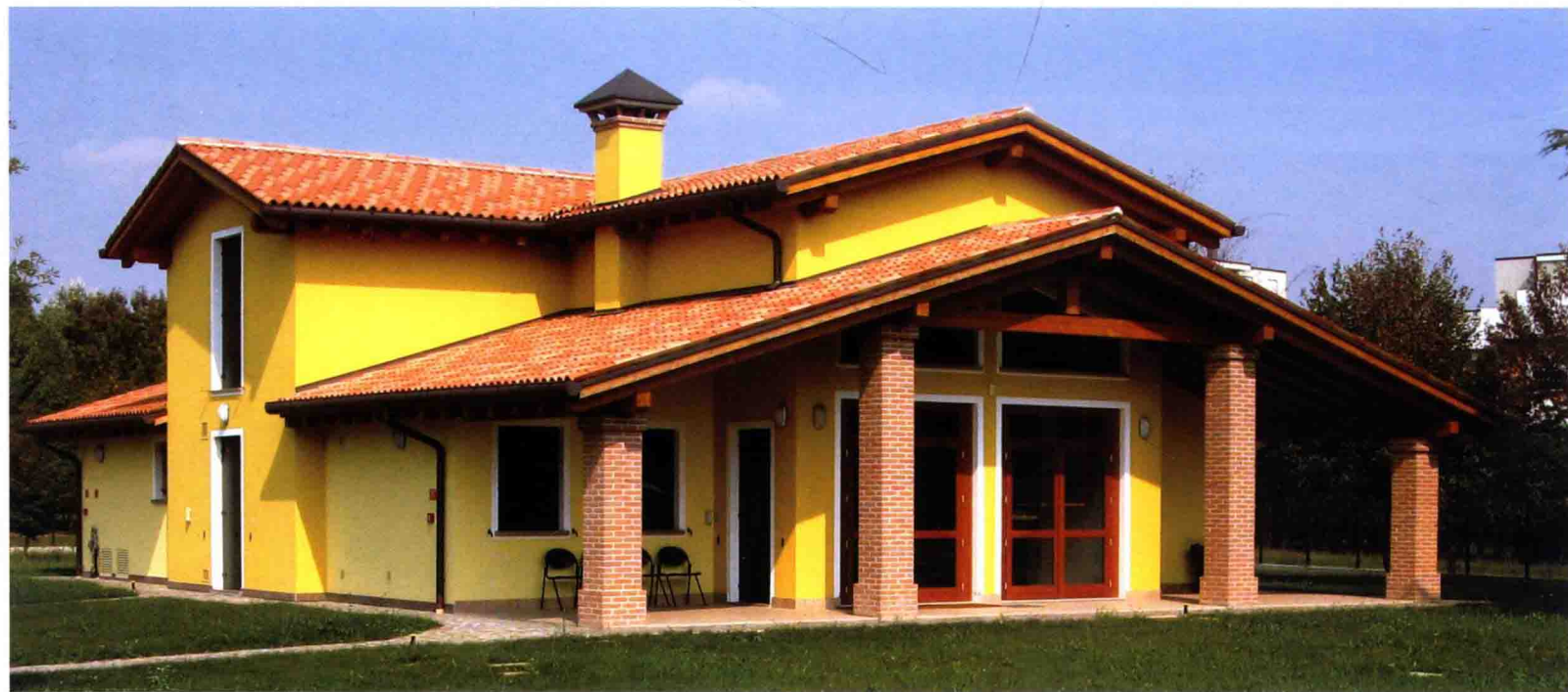
利用平行的两个坡屋面设计出层叠的外观效果，也拓展了建筑外空间。
