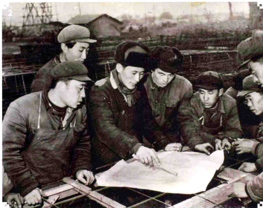
2. 原北京市常务副市长张百发同志在十大建筑工地上。
