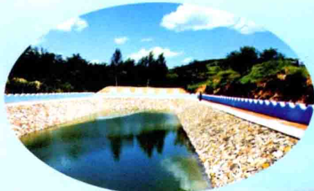
蓄水方塘（双塔区）
