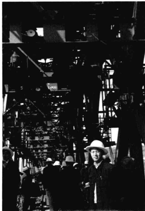
1956年10月于敏在武汉长江大桥工地
