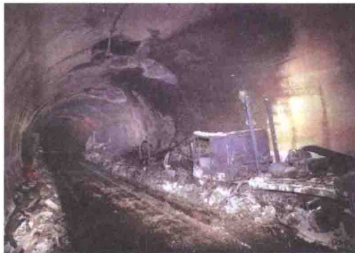
图 1-3 勃朗峰隧道火灾事故现场
