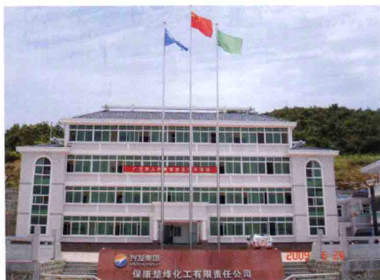
兴发集团楚烽磷矿矿区办公楼
