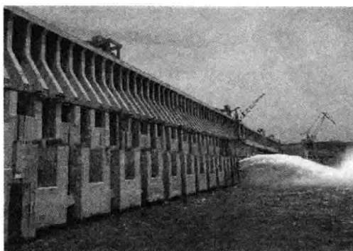
(a) 三峡永久闸门喷锌
