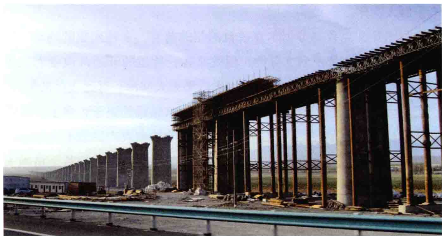
建设中的乌鲁木齐至北京高速铁路
