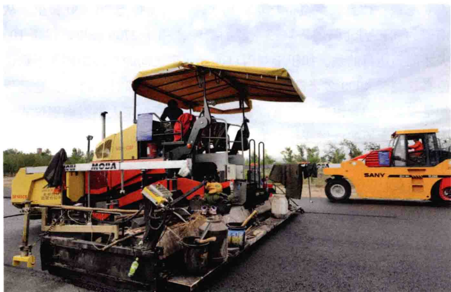
昌吉公路正在建设
