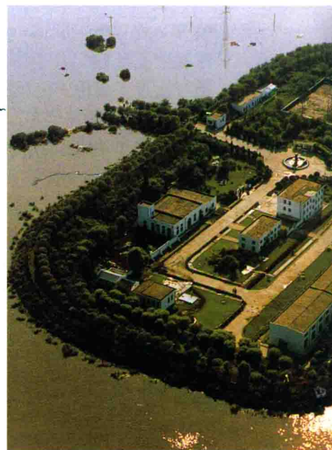
被洪水围困的市自来水公司供水二厂仍然坚持生产，保证汛期生活、生产用水。
