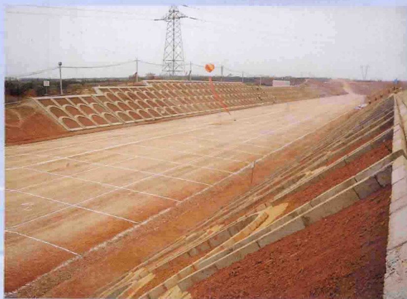
武汉试验段路基
