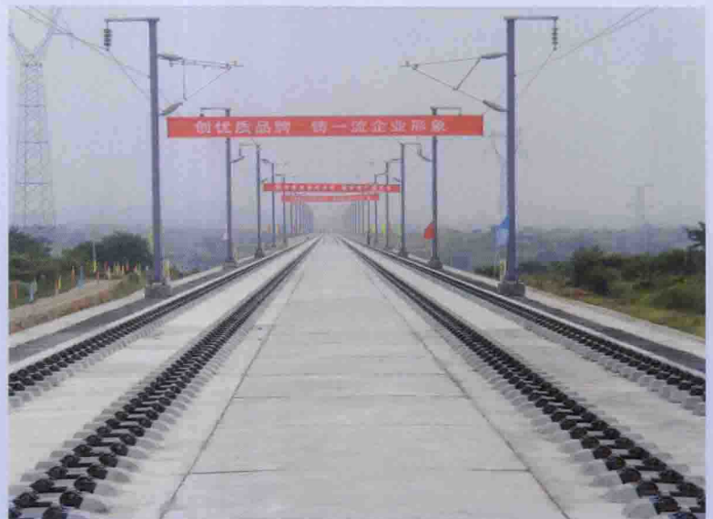
路基上成型无砟轨道道床板
