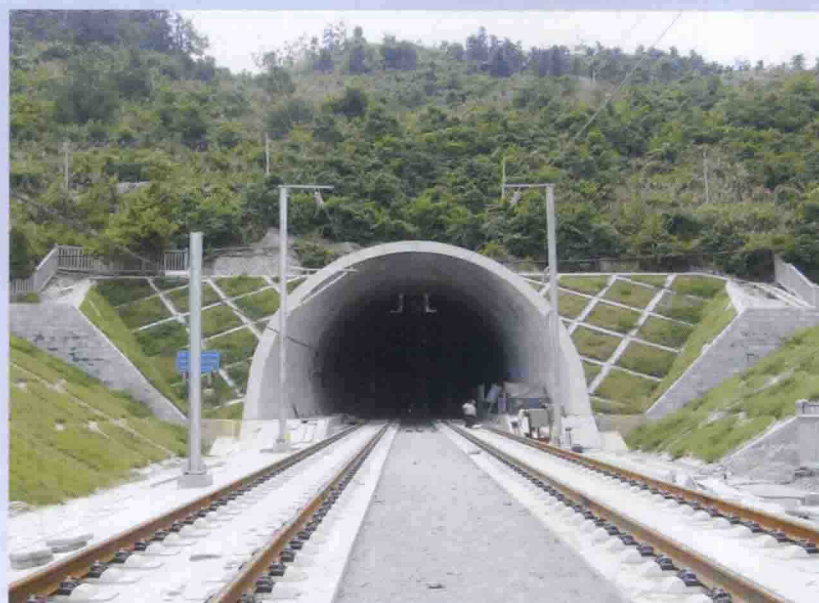
大瑶山1号隧道
