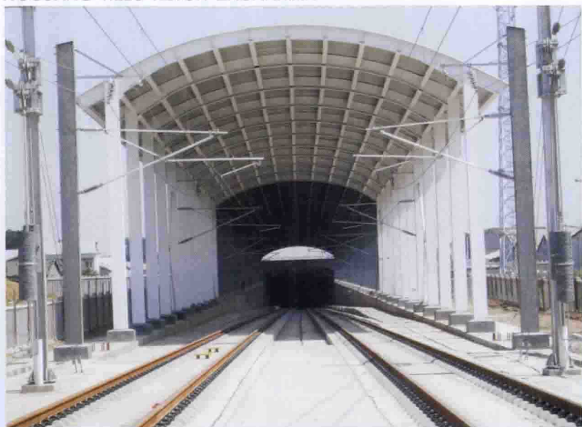
浏阳河隧道出口明洞段
