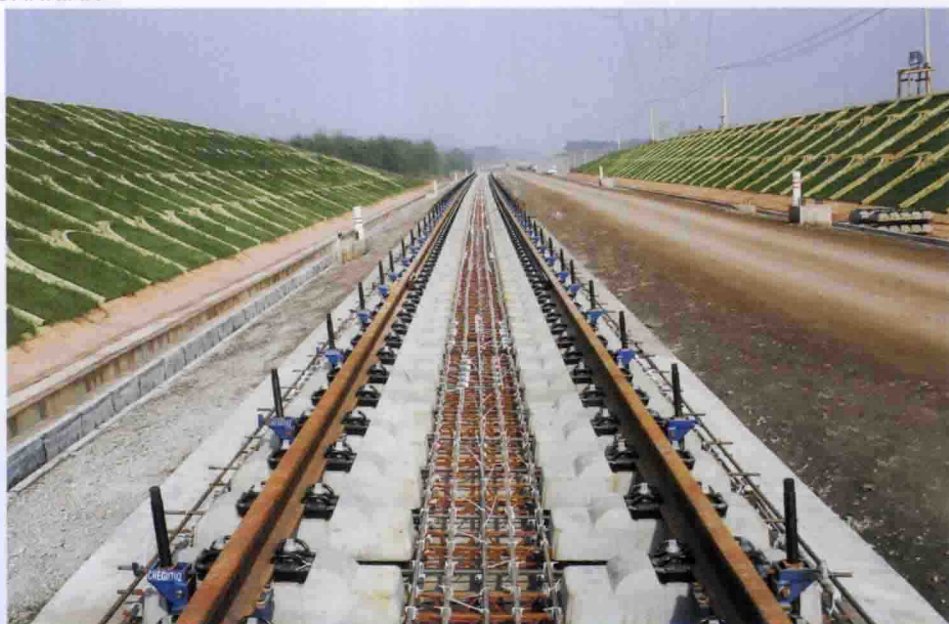
道床板钢筋绑扎
