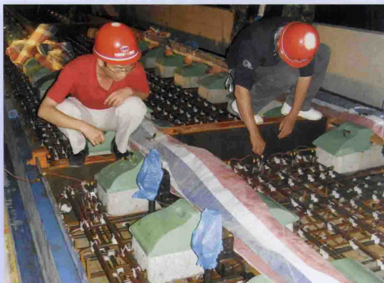
道床板钢筋绝缘测试
