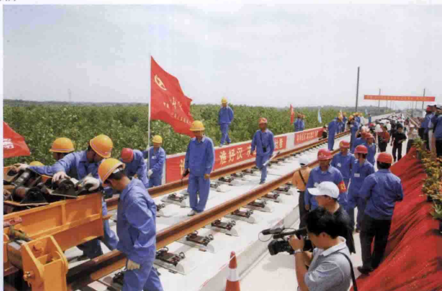
长钢轨现场铺设
