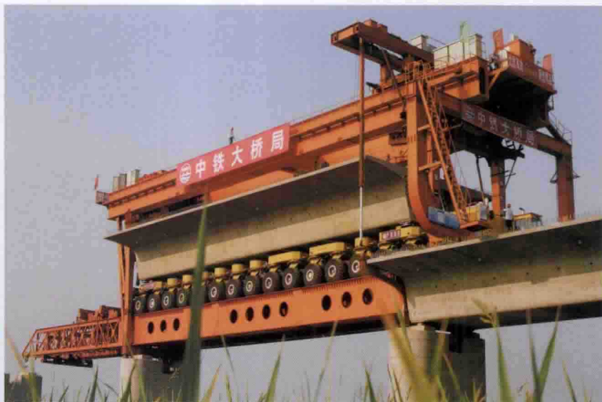
Q900 型下导梁架桥机
