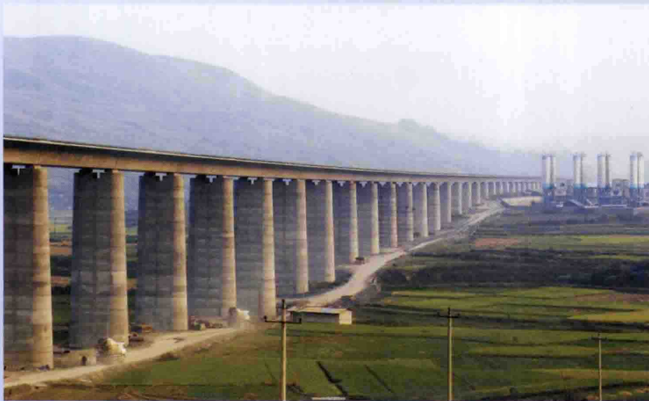
章水河特大桥
