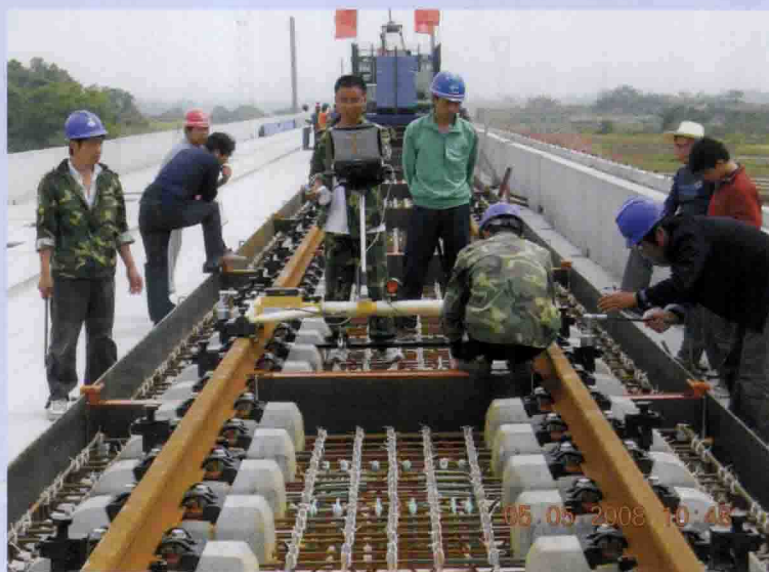
轨道精调作业
