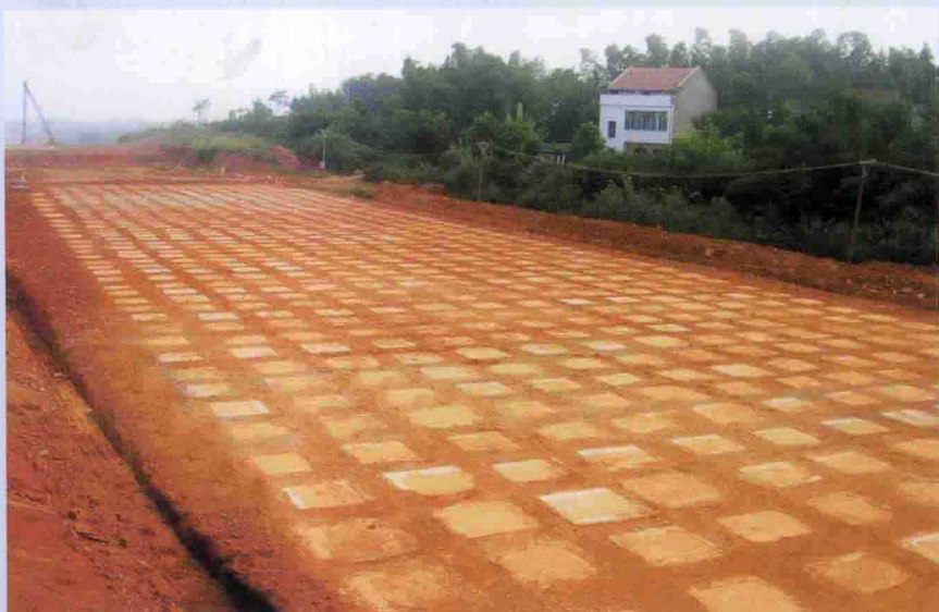
CFG 桩地基加固
