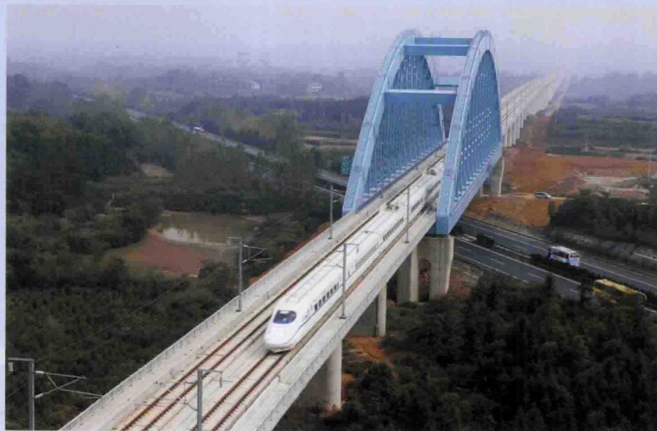
汀泗河特大桥
