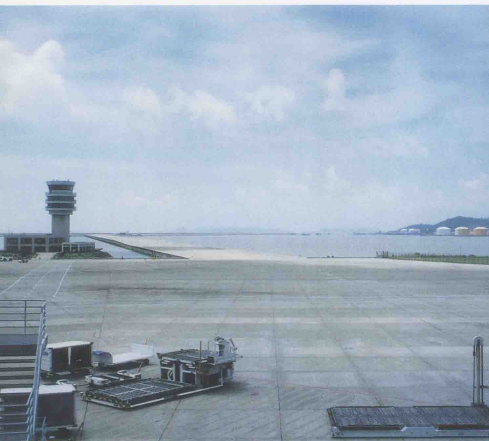
■澳門機場填海造地建成，在兩岸轉機過程中，作用日趨重要。
