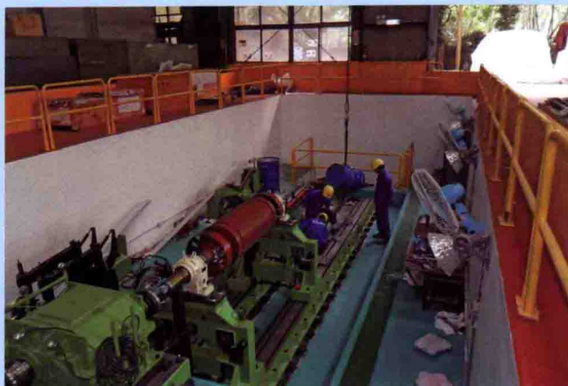
准高速平衡机安装现场
