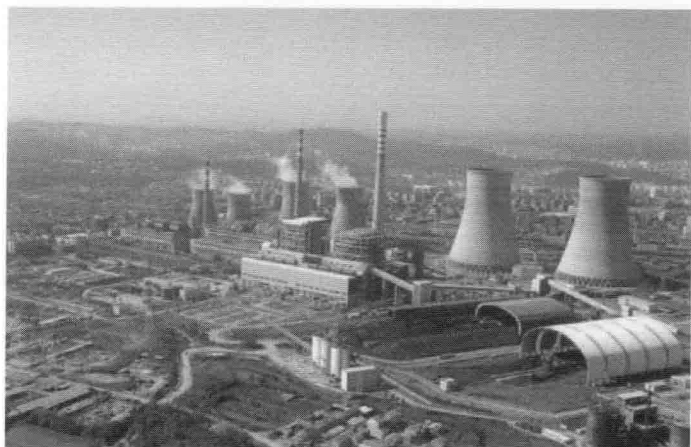
1976年4月，华中电网主力调峰电厂落户荆门东郊。图为荆门热电厂外景。
