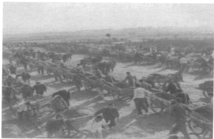
1975年冬，荆门、钟祥、京山三县大规模掀起农田水利基本建设高潮。图为钟祥县广大群众开展农田水利基本建设的场面。
