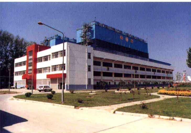
首都机场冷冻站
