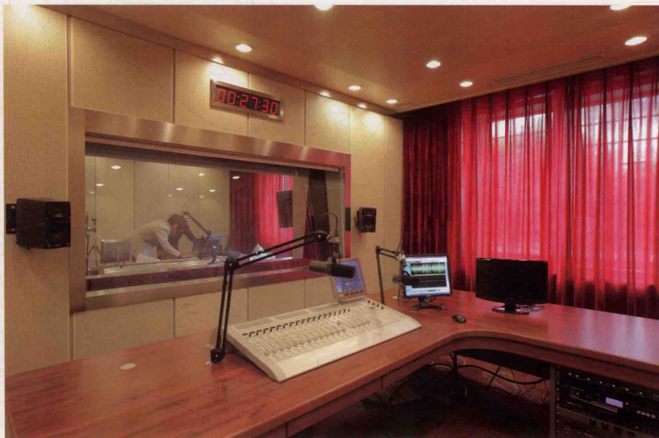
浙江省广电中心录音室
