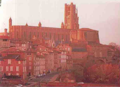
建於鎮中央的大教堂旁的美術館。
