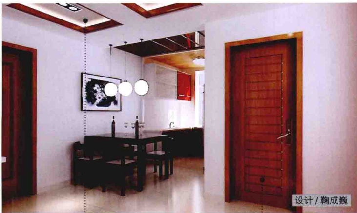
木质方框收边石膏板造型吊顶
