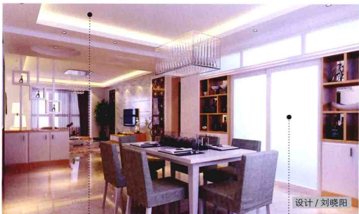
石膏板吊顶造型内藏虚光带
