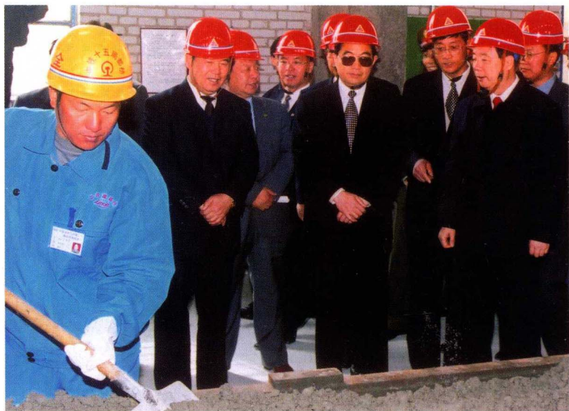
2002年5月27日，时任中共中央政治局常委、国家副主席的胡锦涛（前排右二）在青藏铁路工地视察中国铁建的施工队伍。
