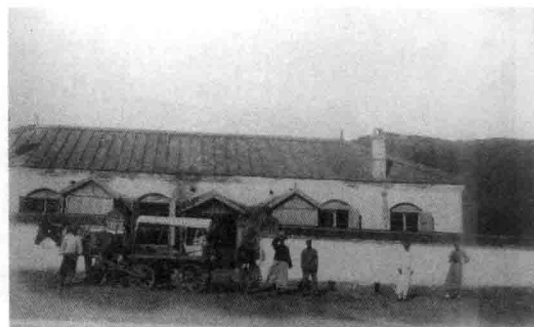
大孤裡沟分所旧址
