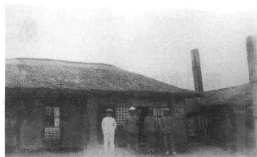
石建坪分所旧址
