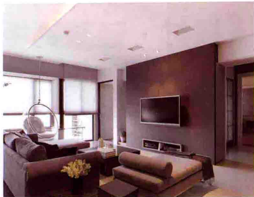
▲家庭吊顶多数为纸面石膏板做主材
