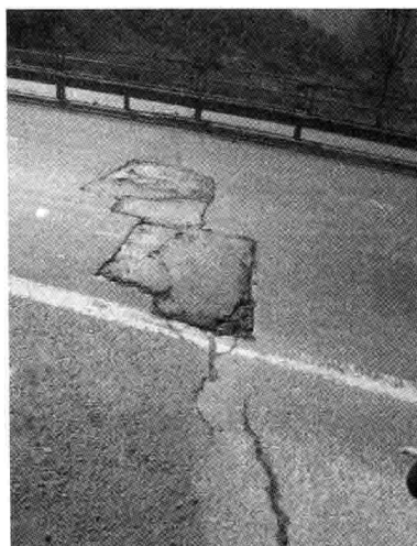
图 1-10 经修补后的路面破损面
