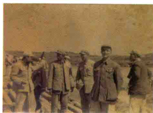
1950年在抢修广汕 公路工地（右二）
