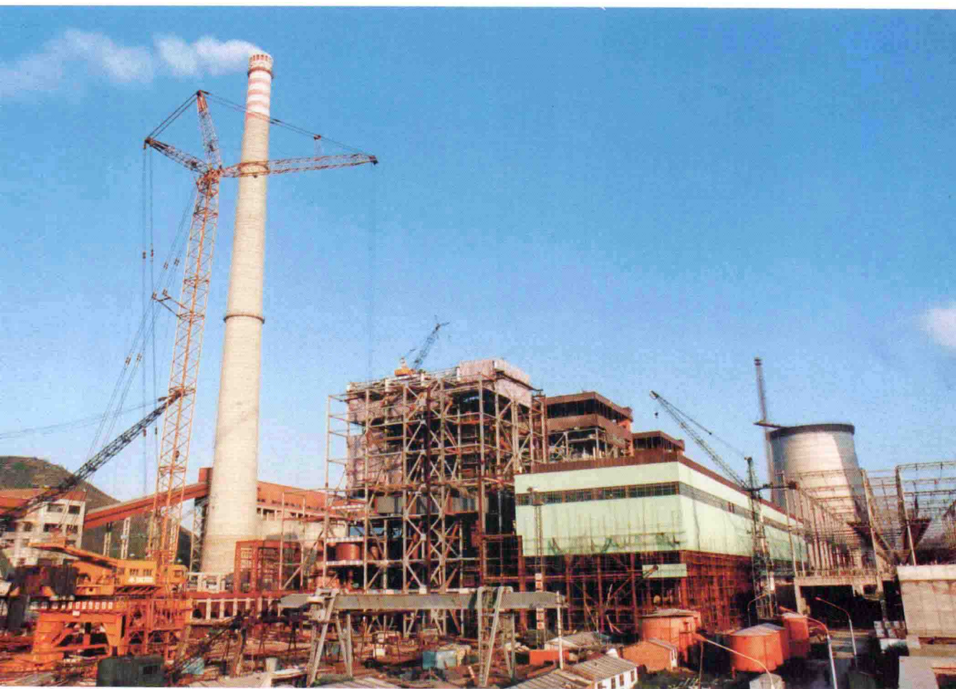
▼建设中的石景山热电厂
