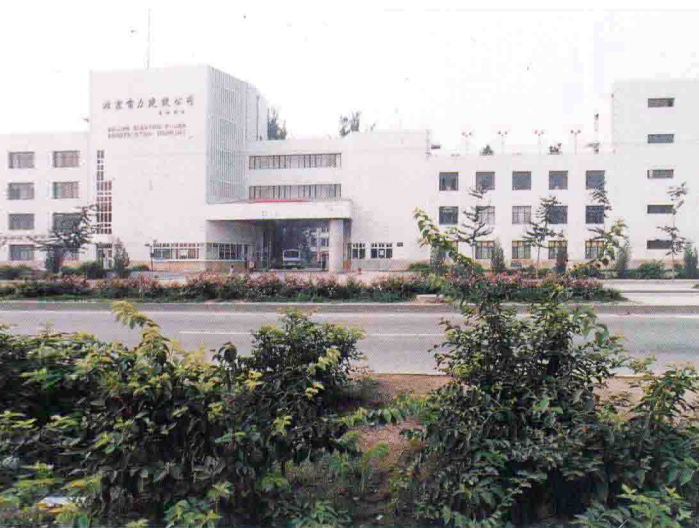
▲北京电力建设公司
