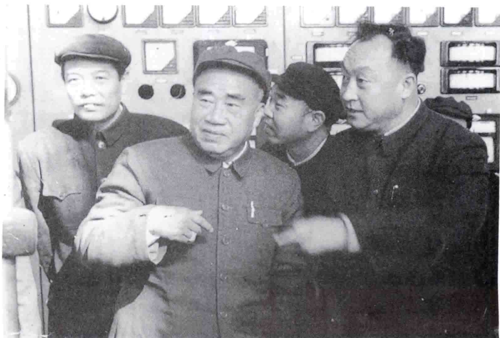
1959年11月2日，朱德委员长视察北京热电厂
