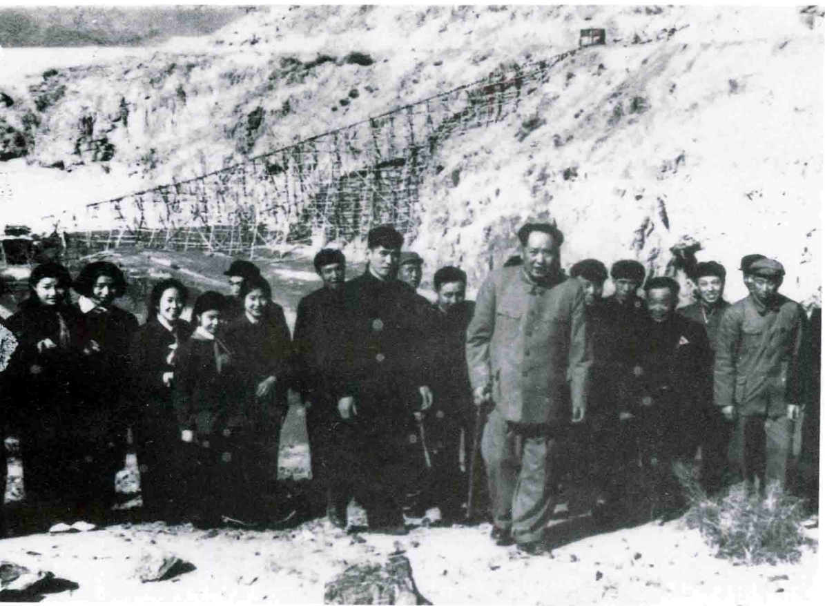
1954年4月，毛泽东主席视察官厅水库及水电站工地
