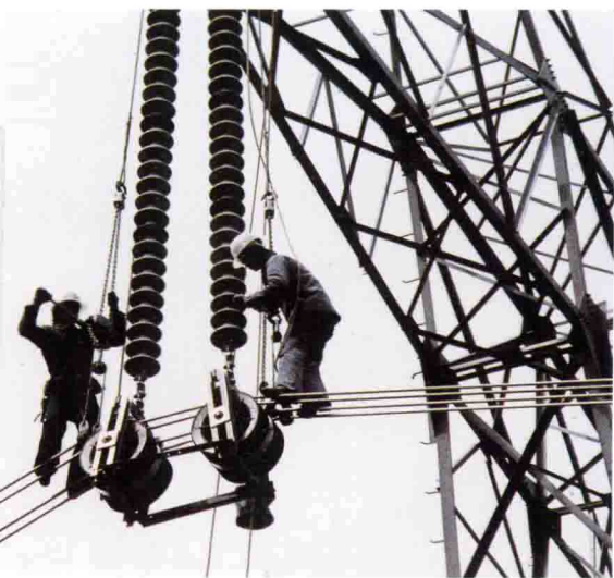
架设 500 千伏输电线路
