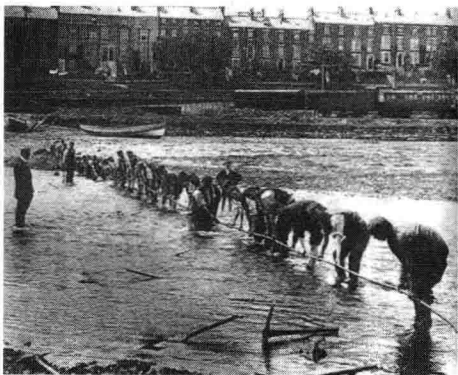
◆美国铺设第一条海底电缆
