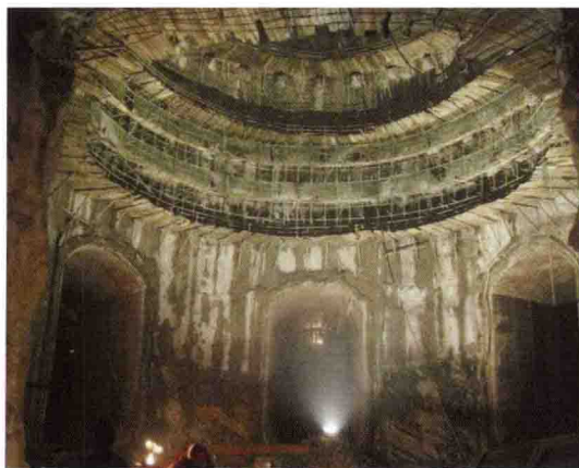
锦屏一级尾调室上游三岔口开挖情况
