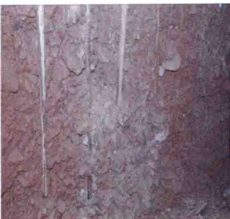
2#引水竖井塌方方段小导管支护效果
