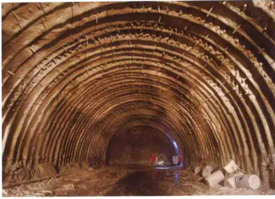
漂蓄2#尾水洞顶拱开挖支护
