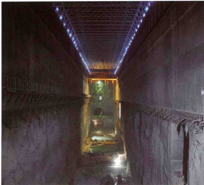
漂蓄地下厂房
