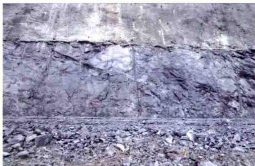
下水库库岸边坡双聚能预裂爆破开挖效果
