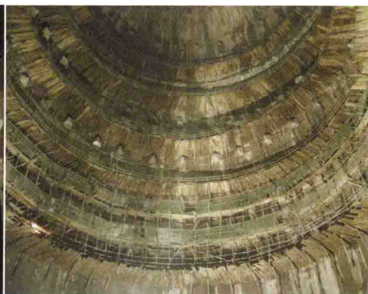
锦屏尾调室分层栈桥平台
