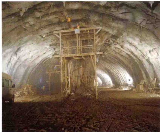
漂蓄主厂房顶拱层开挖
