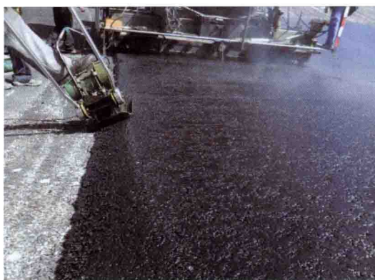
呼蓄沥青混凝土条带缝开放端预处理
