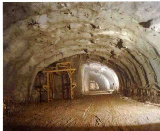
漂蓄主变洞顶拱层开挖
