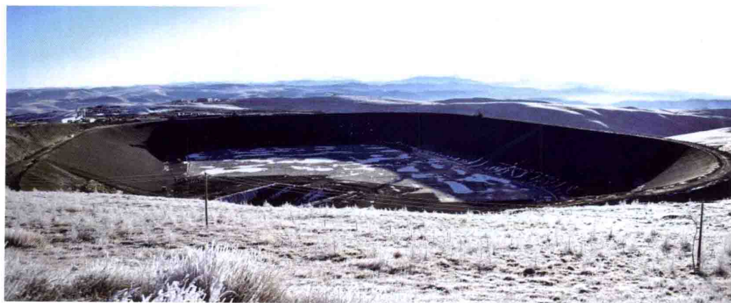
呼蓄电站上水库冬季全貌
