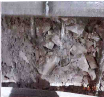
2#引水竖井塌方方段小导管支护效果
