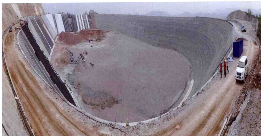
漂蓄上水库库盆施工过程面貌
