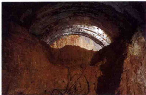
6# 施工支洞不良地质段台阶法开挖支护施工
