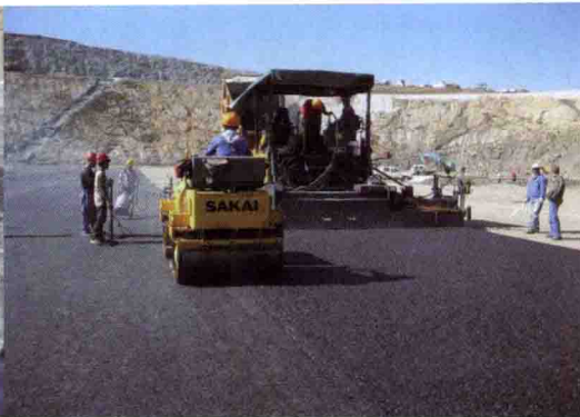
呼蓄库底沥青混凝土摊铺、碾压
