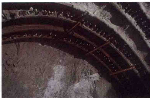
漂蓄尾水洞 F136、137 断层影响区域小导管
