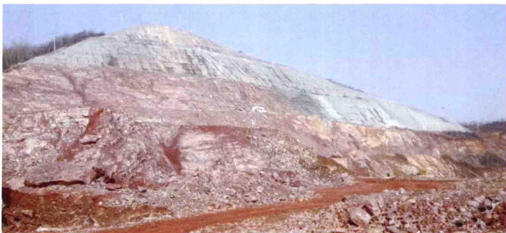
漂蓄上水库西南库岸顺层边坡分层开挖
