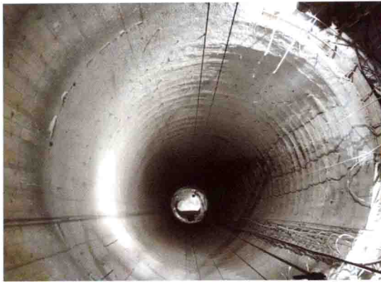
漂蓄2#引水竖井正井开挖
