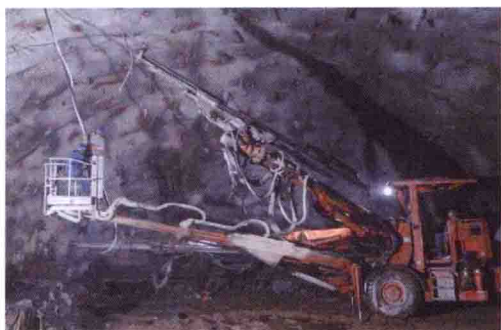
漂蓄尾水调压井穹顶预应力锚杆安装
