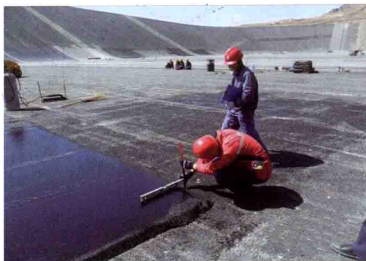
呼蓄库底沥青混凝土摊铺厚度检测
