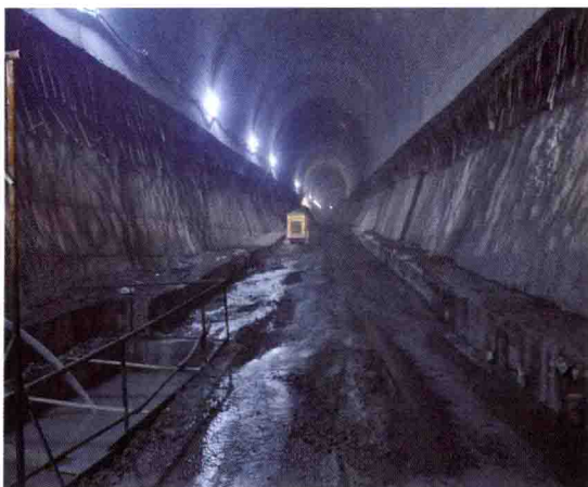
漂蓄尾水洞岩脉段开挖支护、顶拱衬砌混凝土、底拱开挖支护
