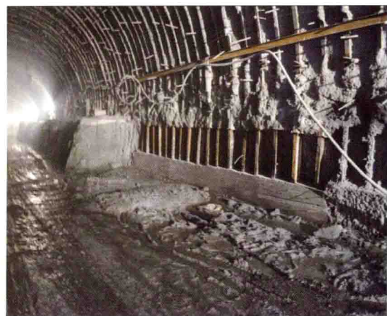
漂蓄尾水洞岩脉段开挖支护、顶拱衬砌混凝土、底拱开挖支护
