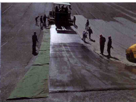
呼蓄沥青混凝土斜坡摊铺施工
