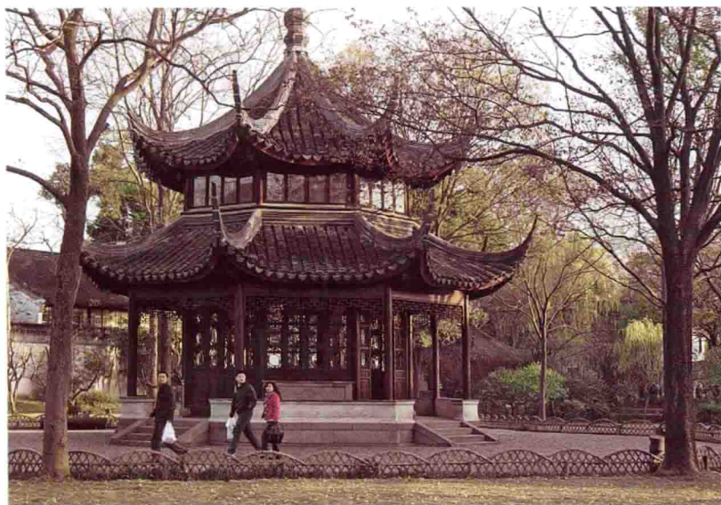
图 13 重檐八角亭（拙政园天泉亭）
