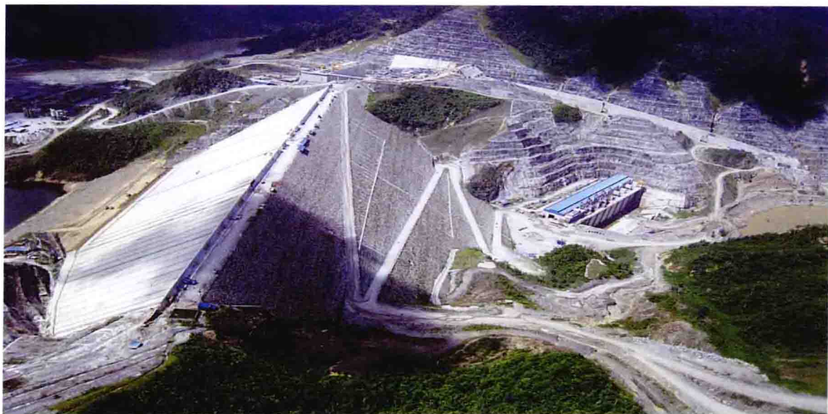
图 1-1 马来西亚巴贡水电站大坝俯视
