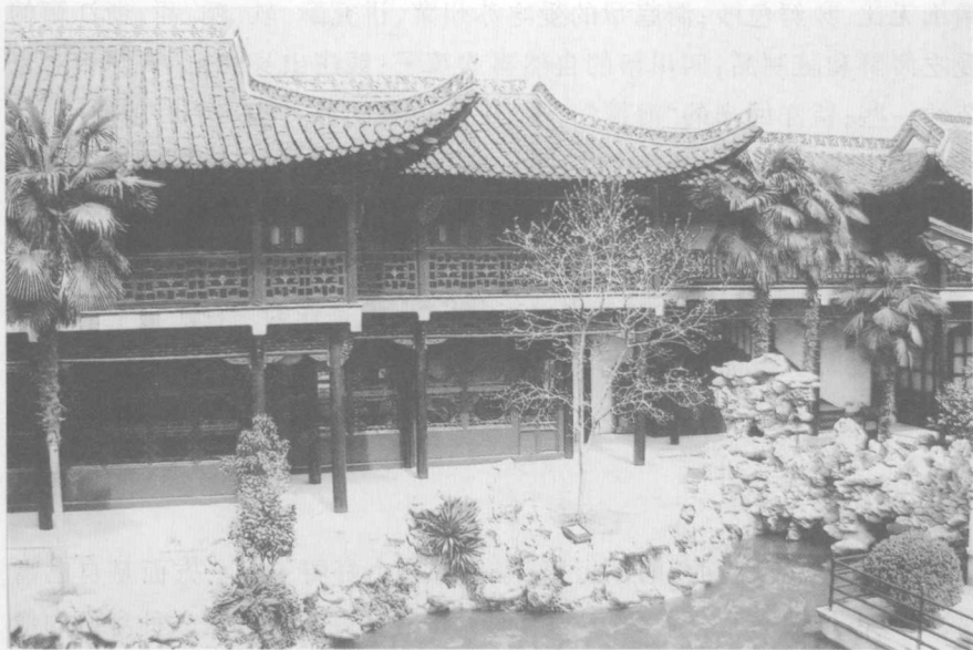
扬州大盐商的餐厅：何园蝴蝶厅
