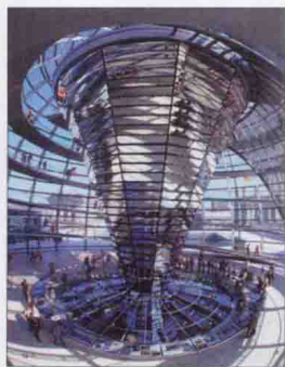
柏林德国国会大厦壮丽雄伟的钢筋玻璃圆顶
