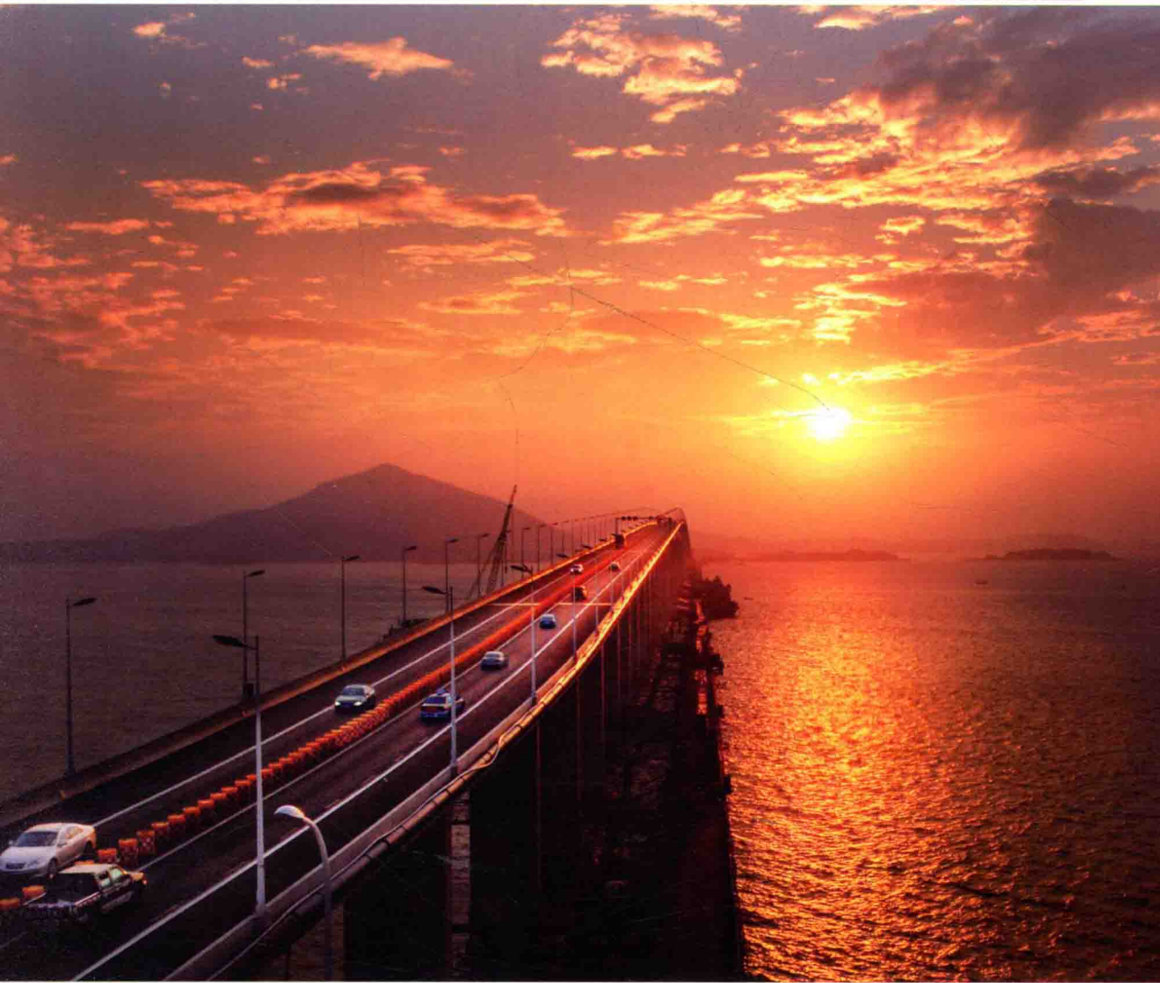
平潭海峡大桥
