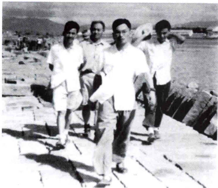
1953年叶飞（前中） 视察福建厦门海堤工程
