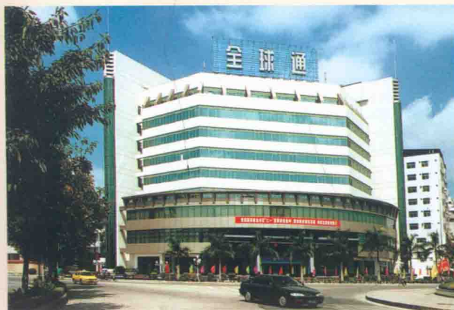
梅州移动大楼（杨焱辉摄）
