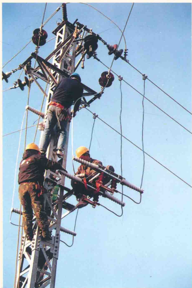
供电部门加快农网改造（钟伟光摄）
