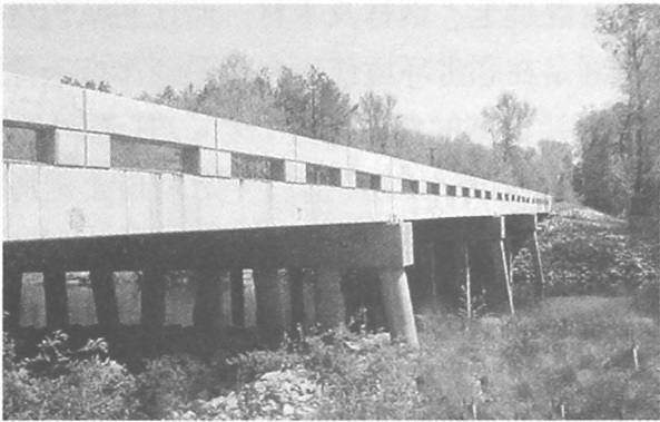
(e) 维吉尼亚的NOTTOWAY桥梁
