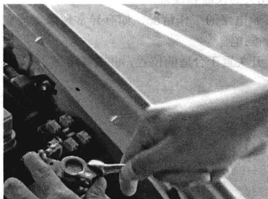
图 1-3 拆开蓄电池正极电缆固定夹
