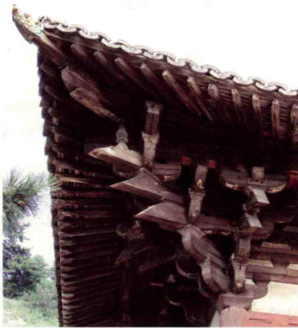
图 1-31 山西五台佛光寺东大殿外檐转角铺作 [佛光寺是一座中型寺院, 位于山西省五台县豆村, 是唐时五台山“十大寺”之一, 正殿建于唐大中十一年 (857 年), 佛光寺大殿现为中国现存历史第二悠久的木结构建筑 (仅次于五台县的南禅寺)。大殿为适应内外槽的平面布局, 在结构上以列柱和柱上的阑额构成内外两圈柱架, 再在柱上用斗拱、明乳袱、明袱和柱头枋等将这两圈柱架紧密联系, 支持内外槽的天花, 形成了大小不同的内外空间, 而在天花以上还有另一套承重结构; 这样天花以下露明的构件——明乳袱、明袱和斗拱等, 可充分地用来组织空间; 外槽前部进深只一间, 斗拱只出一跳, 而外槽高度为进深的 1.7 倍, 构成狭而高的空间]
