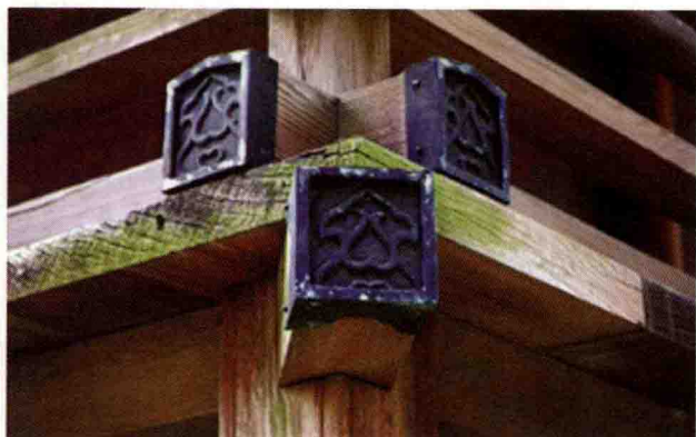
图 1-10 桃园神社建筑五金构件
