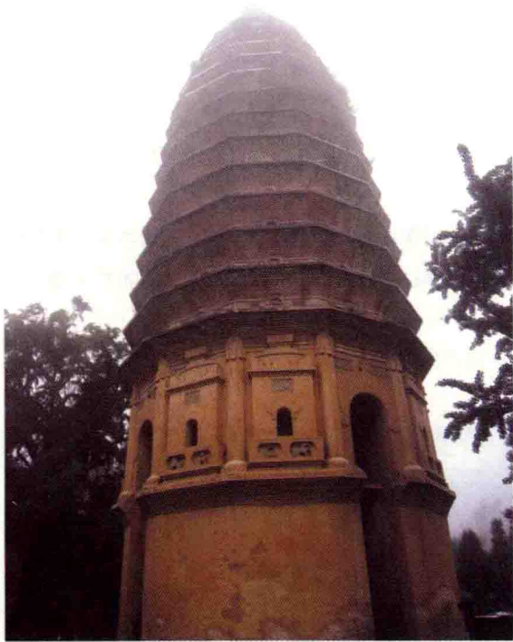
图 1-30 河南登封嵩岳寺塔 [嵩岳寺塔位于河南省登封市西北 5 公里的嵩山南麓嵩岳寺内, 该塔始建于北魏正光元年 (520 年), 是中国现存最古老的砖塔。塔是由青砖和黄泥砌筑成的 15 层密檐式砖塔, 平面呈十二边形。寺塔总高 37.045 米, 底层直径 10.6 米, 内径 5 米多, 墙体厚 2.5 米。塔的外部, 分别由“基石”、“塔身”和“宝刹”组成。全塔共雕 16 个狮子, 有立有卧, 正侧各异, 造型雄健]
