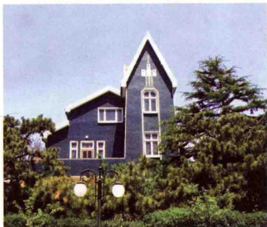
图 1-23 山东青岛公主楼（青岛公主楼是一座丹麦式建筑，其外部由一组不规则斜顶屋面组成，南侧为一宽敞的方形露台，绿色外墙，宛如安徒生的童话世界）
