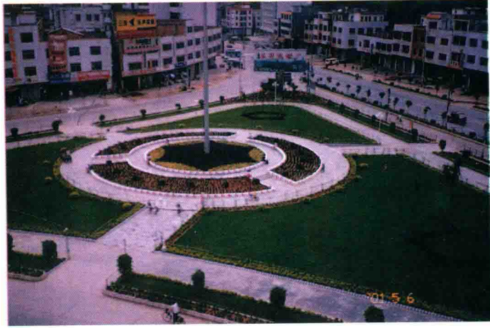
县公路局投资兴建的华城街心花园
