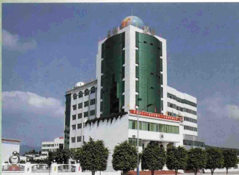
梅县环保局新建的办公大楼。这是县环保局和县环境监测站开展环保工作的基地
