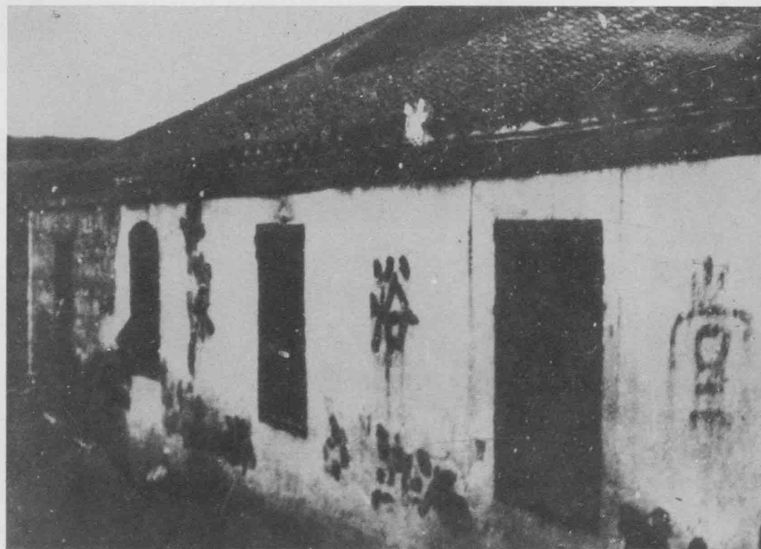
1923年2月9日，南京两浦铁路工人大罢工指挥部旧址——浦镇浴堂街34号（现为“二七”纪念馆）。
