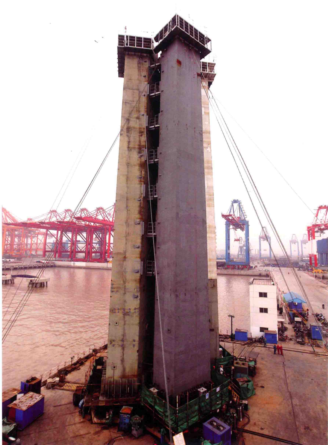
美国旧金山新海湾桥钢塔
