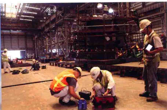
钢桥监理检查
