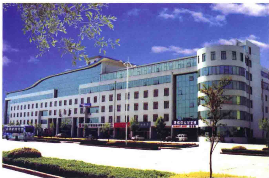
山东兴华建设集团开发建设的港航服务中心工程
