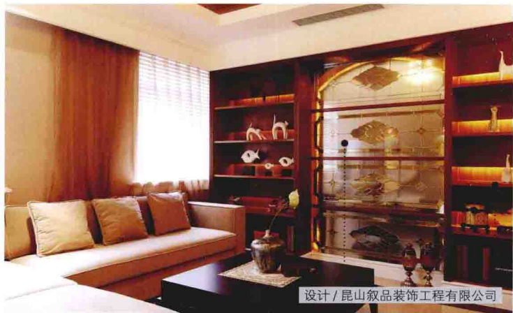
木质边口内嵌磨砂花式玻璃 木工隔板表面喷漆处理
