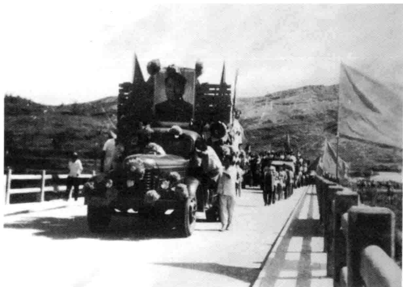
1968年8月1日，野河大桥建成通车。
