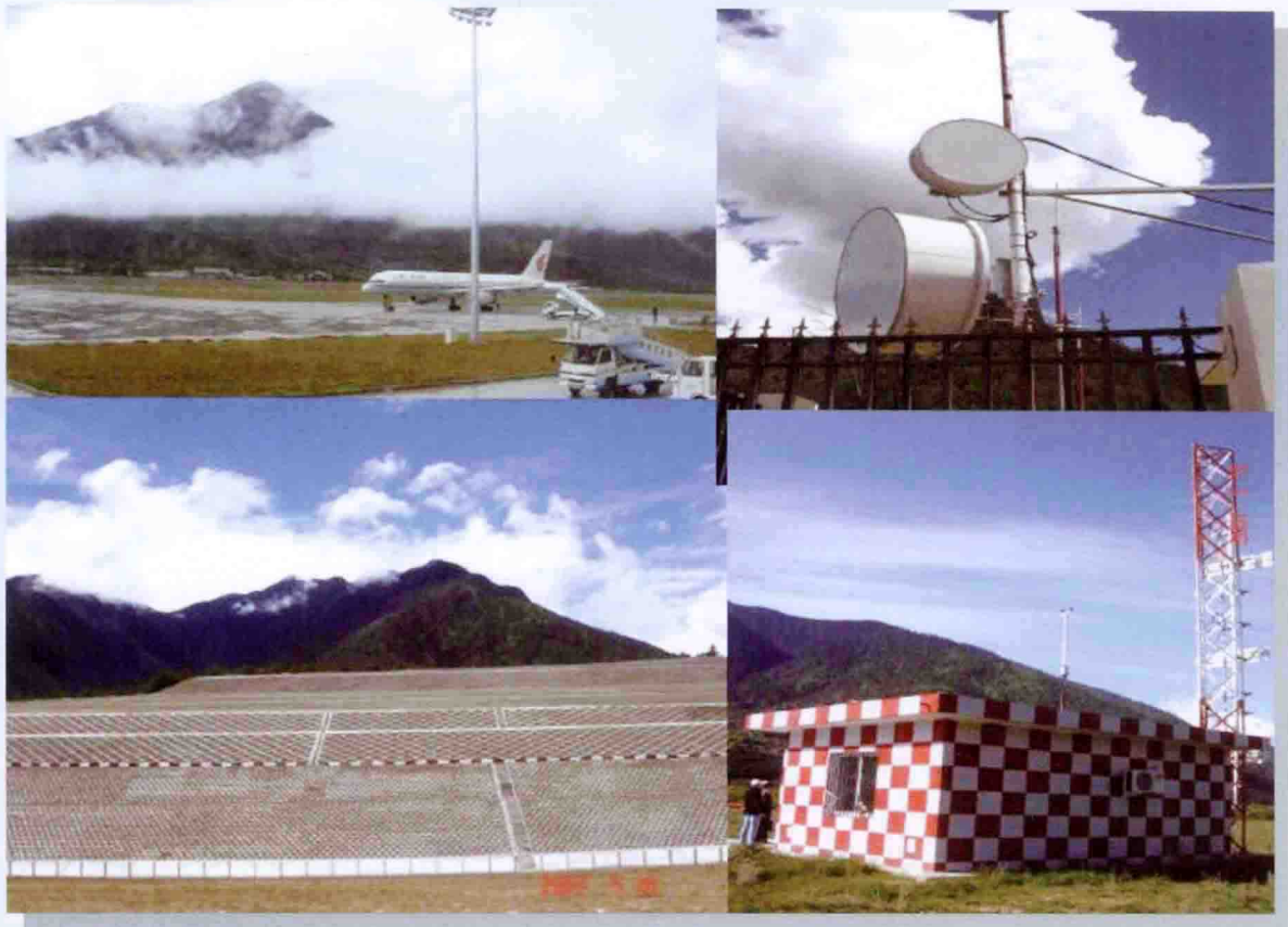
自2004年9月起，中国民用航空总局空中交通管理局在林芝机场开展了GBAS试验系统的探索和研究开发工作。图为设置于林芝机场的GBAS试验系统。
