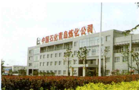
公司生产调度楼
